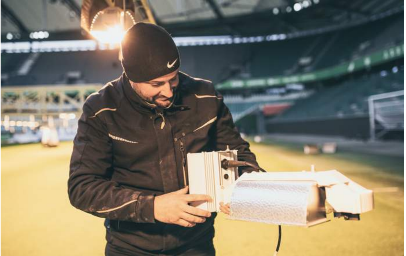
Greenkeeper Andreas Stuber wechselt die Lampen des Beleuchtungssystems. Diese sind auf meterlangen Gerüsten montiert. In der dunklen Jahreszeit leuchten die Lampen fast rund um die Uhr – auch nachts.
